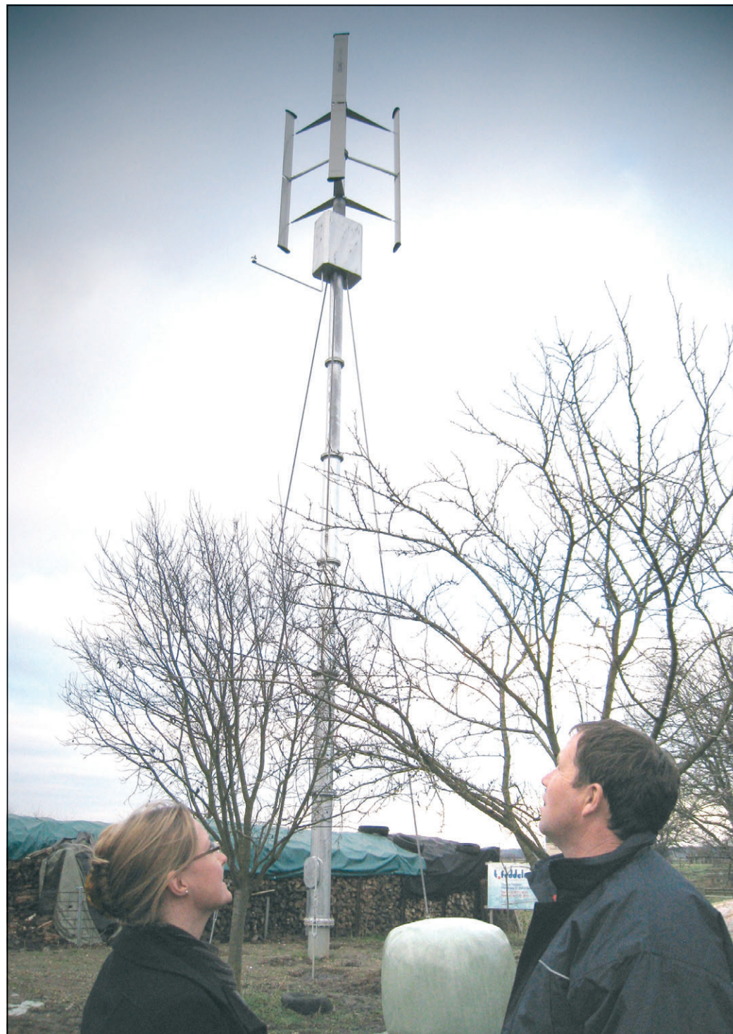
Bald dreht sich der Rotor: In Norddrebber wird demnächst der Prototyp einer Klein-Windkraftanlage in Betrieb genommen. Petra und Thomas Feddeler testen die erste Anlage dieser Art in Deutschland.
